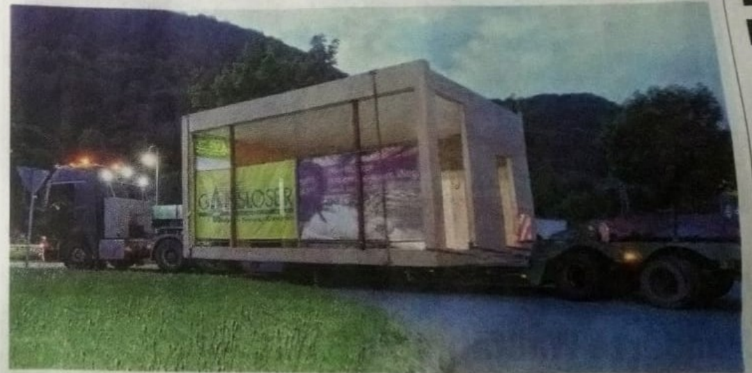
Aus zwei jeweils neun Tonnen schweren Modulen besteht die neue Filiale. Bei den Holz-Containern handelt es sich um ein Pilot-Projekt der Firma Gansloser Holzbau.
